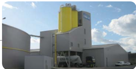
TERMINAL CLINKER automatique : « déchargement wagons, mise en stock, Reprise et chargement bateaux » Débit : 800 t/h.
