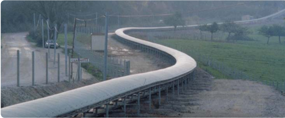
Curvodic™ de 1,1 km en France Liaison usine-gare en agrégats à 1 000 t/h 3 rayons en S.
