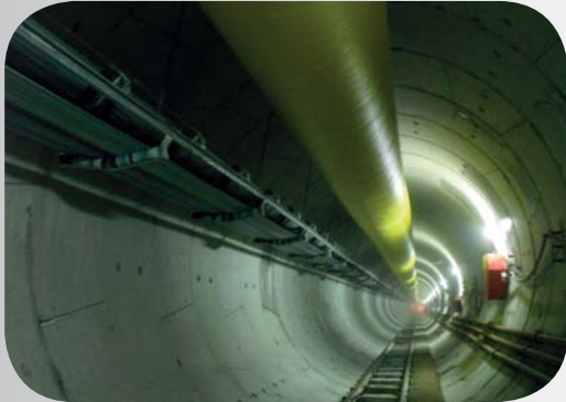
Transporteur suspendu par chaîne Belt conveyor suspended by chain
