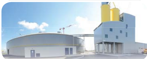
TERMINAL CIMENTIER. Déchargement par trémie dépeussière et manutention à 600 t/h. Stockage de 20 000 T. Reprise automatique, ensachage ou chargement camions à 200 t/h - Stockage palettes de 2 400 m 2
