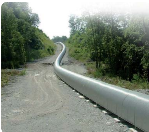
Curvodic™ de 1,8 km en France Liaison carrière-cimenterie en calcaire à 1 200 t/h 4 rayons de 500 m à 1200 m Passage zone NATURA 2000
