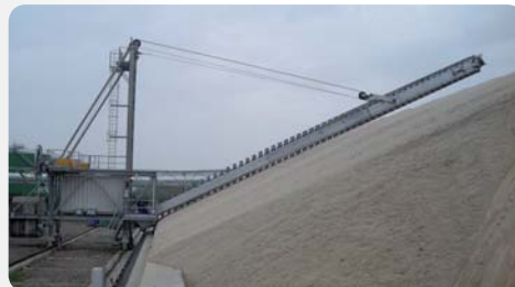
Reprise par grappeur latéral à 250 t/h de laitier. Longueur de flèche : 26 m - Hauteur de tas : 13 m Angle de travail : 42° Reclaiming of slag by lateral scraper at 250 t/h. Boom length : 26 m - Stockpile height : 13 m Slope angle : 42°
