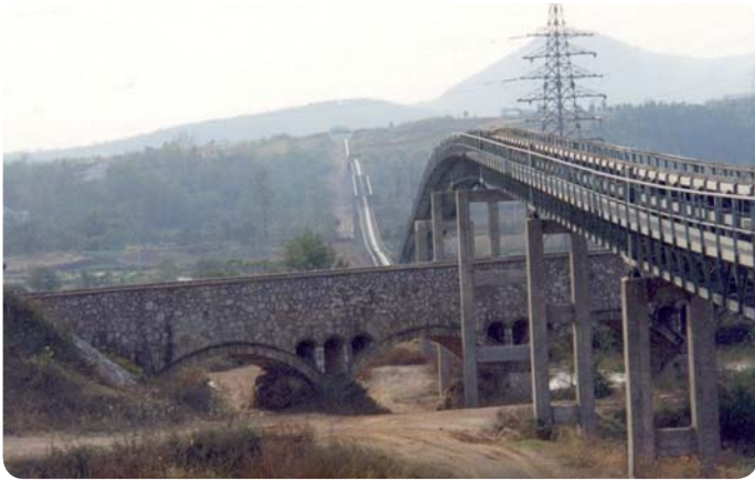
Curvodic™ de 16 km en Chine Liaison carrière-cimenterie en calcaire à 2 000 t/h 8 rayons d'environ 2 500 m
